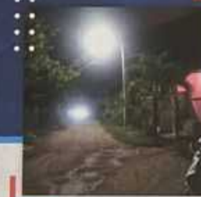
TRABAJOS DE ALUMBRADO
